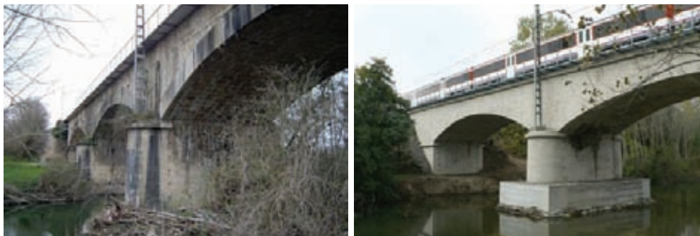
Fig. 9. Puente ferroviario sobre el río Zadorra antes y después de la intervención
