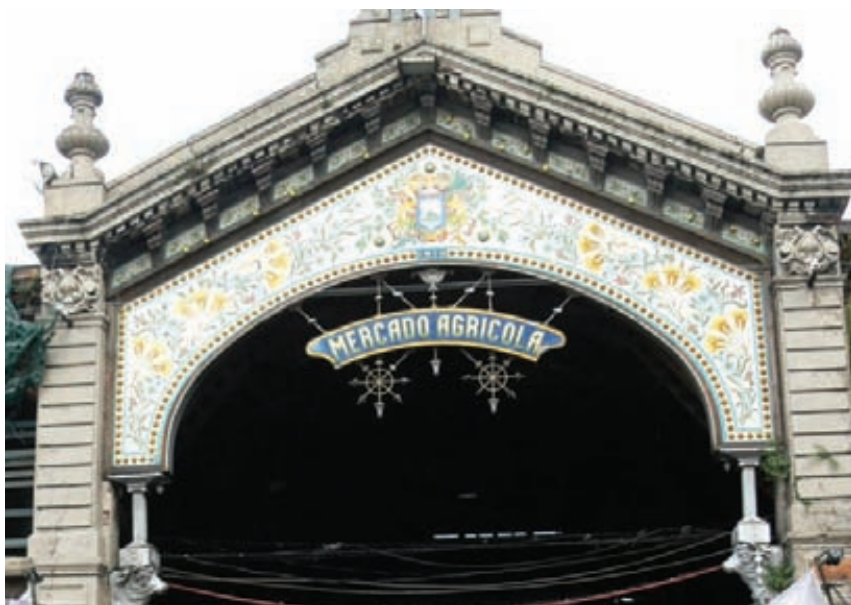
Fig. 8. Entrada acceso rodado fachada principal
