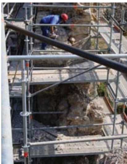
Fig. 16. Desmontaje parcial y acopio de mampuestos
