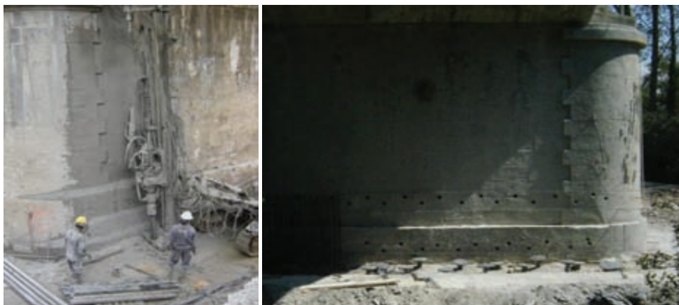
Fig. 13. Ejecución de micropilotes e, inmediatamente después, ejecución de los taladros en pilas en el puente sobre el río Zadorra.
