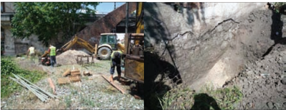
Fig. 24: Campaña de ensayos geotécnicos
