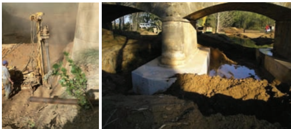
Fig. 6. Ejecución de los micropilotes inclinados y resultado del recalce.
