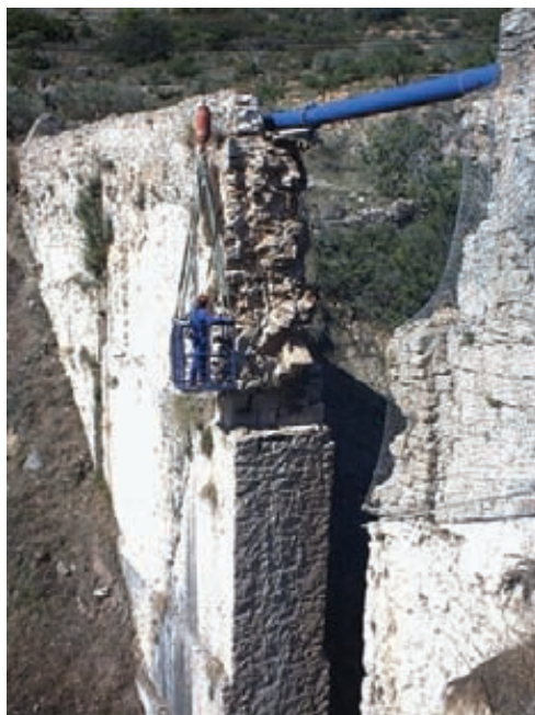
Fig.14. Protecciones y conducción provisional
