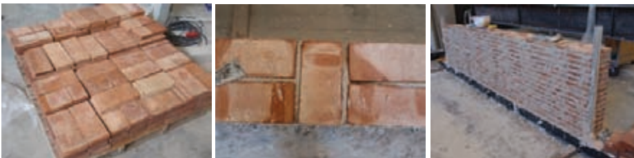
Fig. 3. Construcción del muro
