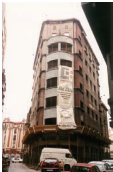
Fig. 1. Estado inicial del edificio.
