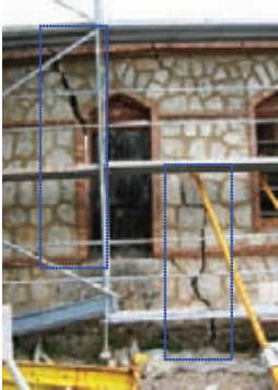
Fig. 20: Daños exteriores en los muros de carga de piedra y ladrillo.
