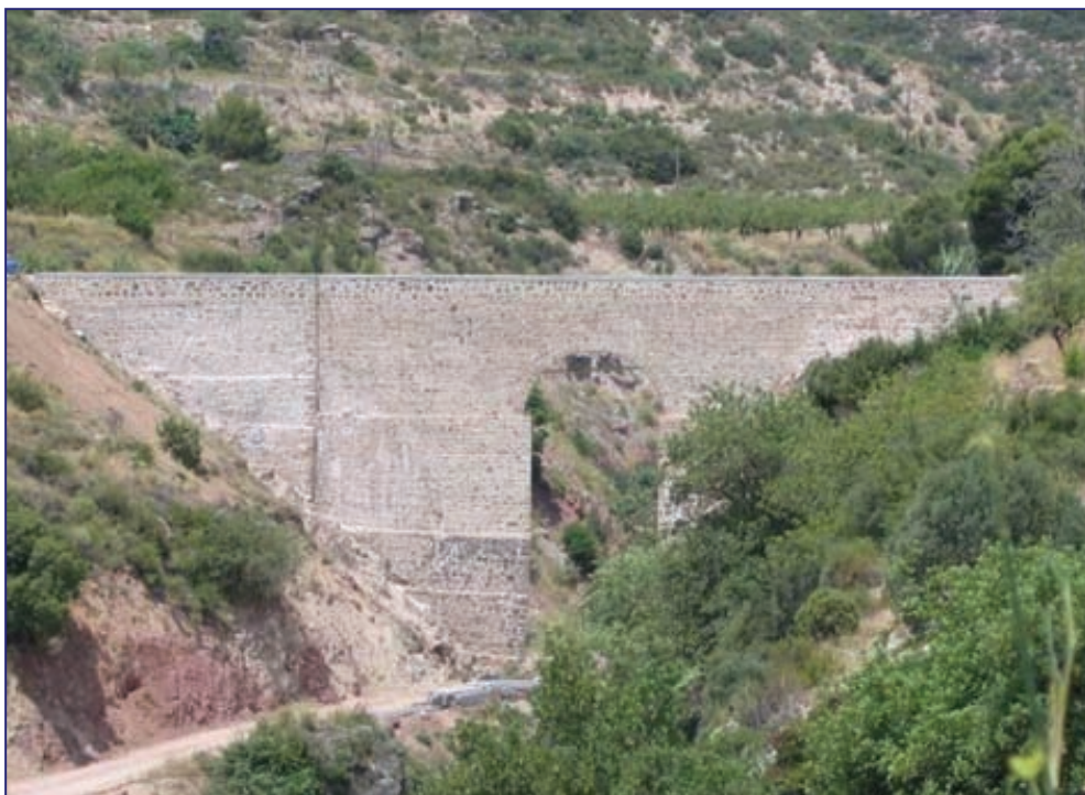
Fig.22. El Acueducto Restaurado y en servicio
