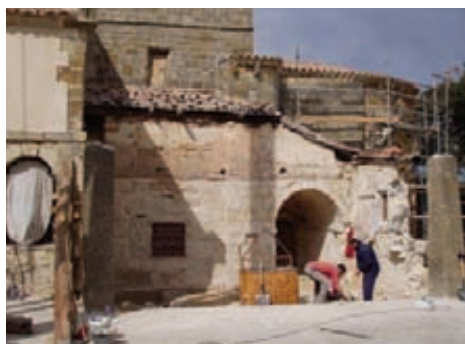
Fig. 6: Desmontaje del muro sur de la sacristía.
