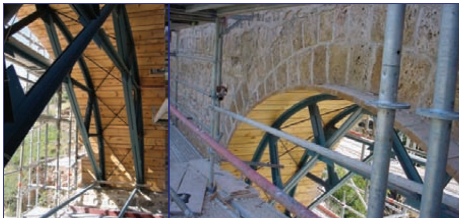
Fig.20. Cimbrado y Reconstrucción de Arco
