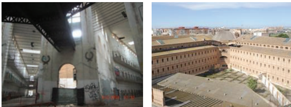
Fig. 2. Cárcel modelo de Valencia (vista interior y exterior)
