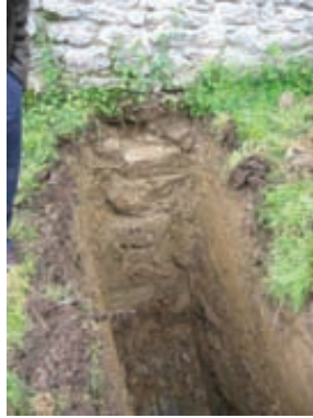
Fig. 22: Recrecidos en la cimentación, lado interior, del muro Este (sondeo 2).
