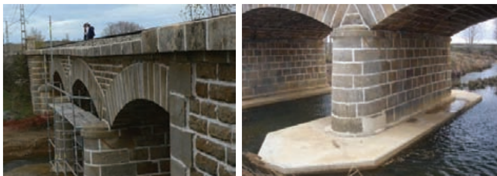
Fig. 7. Ejecución de los micropilotes inclinados, disposición de la ferralla y resultado del recalce.
