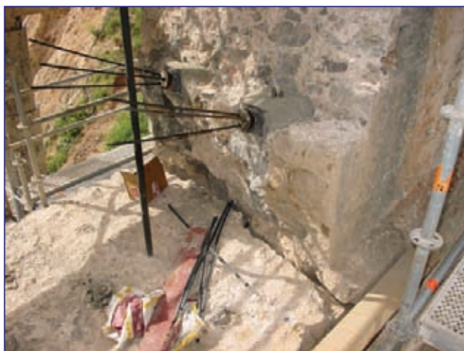
Fig.18. Anclajes Activos de Estabilización
