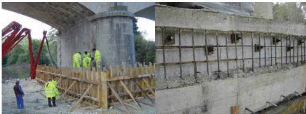
Fig. 14. Montaje del encofrado de uno de los encepados y vista de los cajetines de pretensado de las barras.
