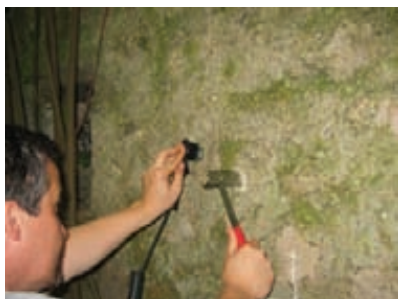
Fig. 9: Ensayo de impacto eco en el interior del muro Sur.
