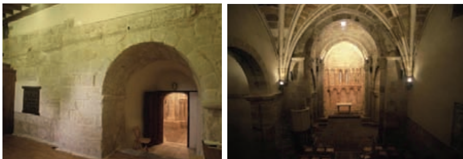
Fig. 8 y 9: Aspecto interior tras rehabilitación.
