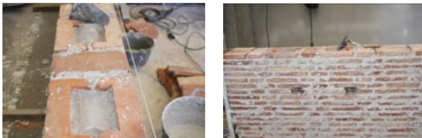
Fig. 2. Imagen los defectos introducidos durante el proceso de fabricación.
