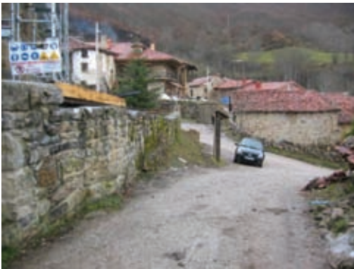
Fig. 25: Excavación, aldeaña al muro de cierre perimetral, ejecutada para materializar el cajeadado de la explanada del vial existente al Este de la iglesia.
