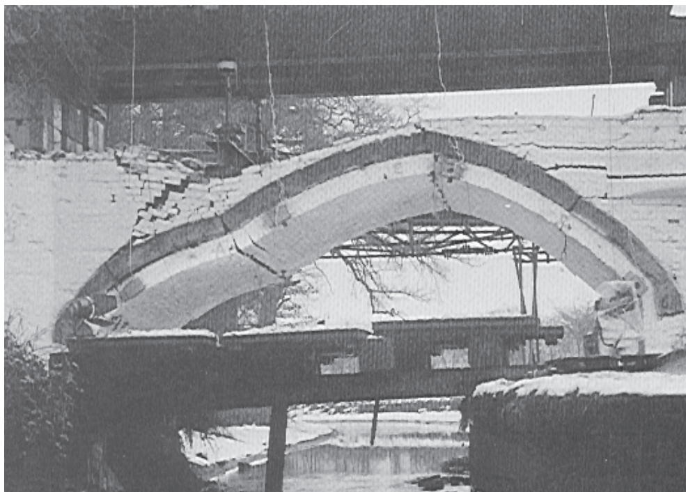
Fig. 17. Ensayo hasta rotura de un puente inglés.
