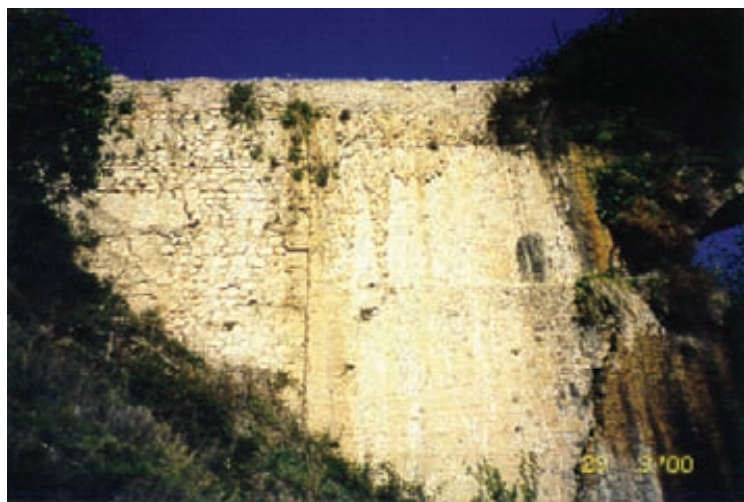
Fig.3. Vista de la fábrica del estribo de la margen derecha
