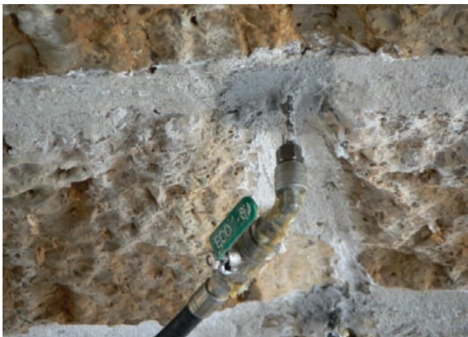
Fig. 8. Inyección de intradós de bóveda en la intersección de llagas y tendeles con emulsión de silicona para la impermeabilización del trasdós de la bóveda.
