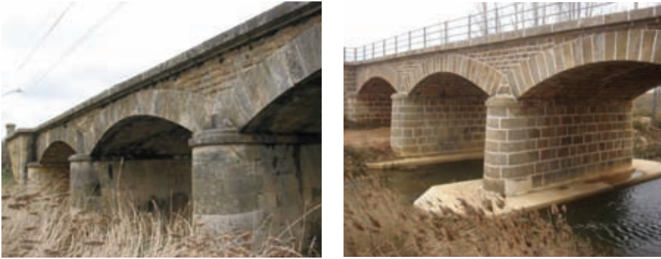
Fig. 1. Puente sobre el río Boedo, antes y después de la intervención.
