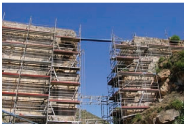
Fig. 15. Andamiaje y apeos del acueducto
