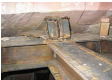
Fig. 42: Posible fenómeno de punzonamiento de la cúpula a nivel del entronque con la linterna.
