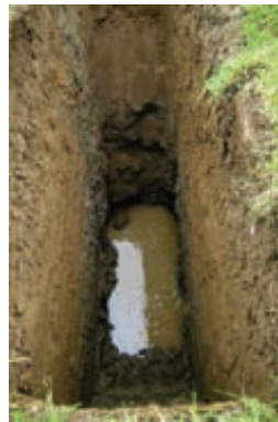
Fig. 25: Excavación, aldeaña al muro de cierre perimetral, ejecutada para materializar el cajeadado de la explanada del vial existente al Este de la iglesia.
