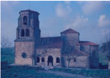
Fig. 1: Aspecto de la iglesia antes de la intervención.
